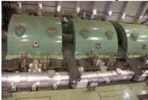
Edifício da Turbina – Angra 2
