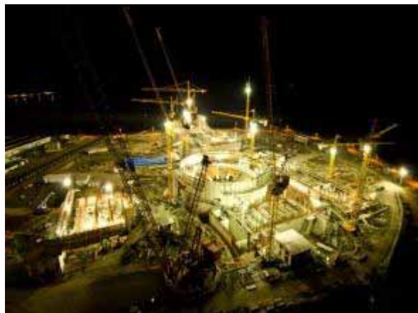
Construção de Angra 3 – Vista Noturna
