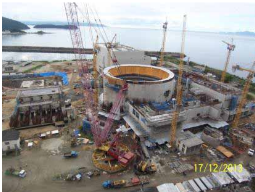
Status da construção de Angra 3 (12/ 2013) Edifício do Reator ao centro
