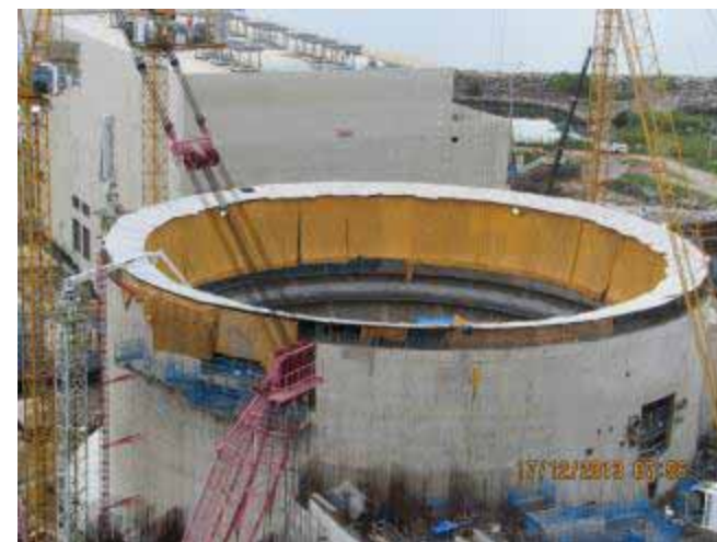
Status da construção de Angra 3 (12/ 2013) Edifício do Reator
