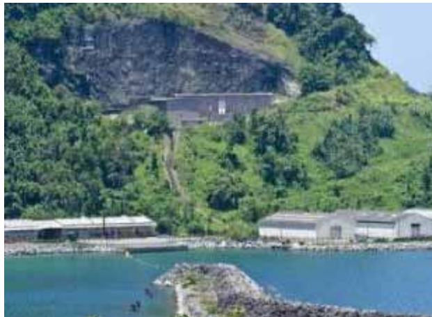
Instalações do Deposito intermediário de rejeitos
